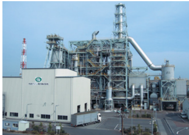
三井造船千葉事業所(千葉県市原市)内の発電設備
