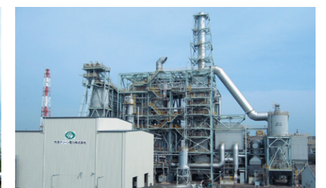
バイオマス発電プラント Biomass power plant
