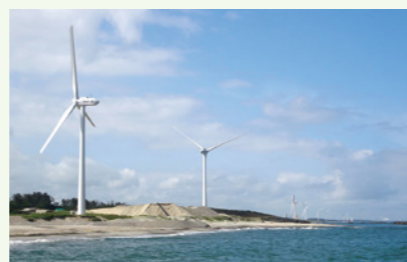
胎内風力発電所(竣工時)
