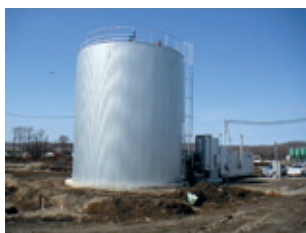
バイオガスプラント
