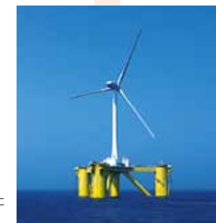
福島沖に設置された風車
