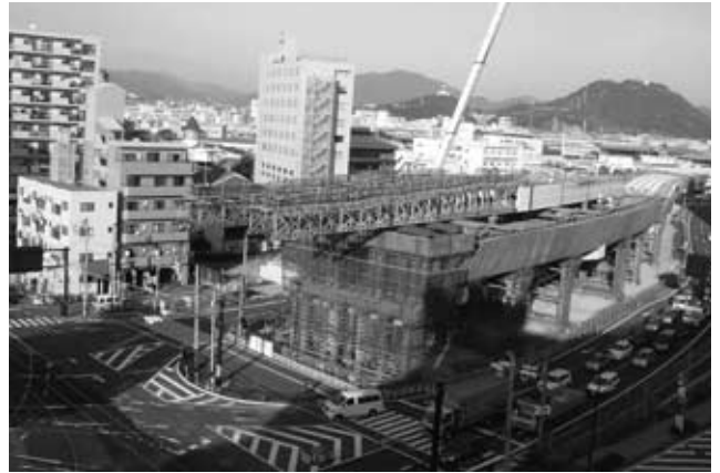
写真2 送出し架設
