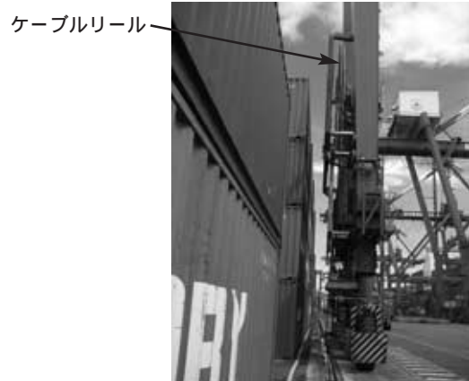
写真2 ケーブルリールによる地上給電装置
