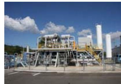
FGSS : Fuel Gas Supply System = 燃料ガス供給システム
