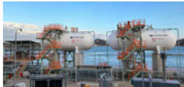
アンモニア供給設備
