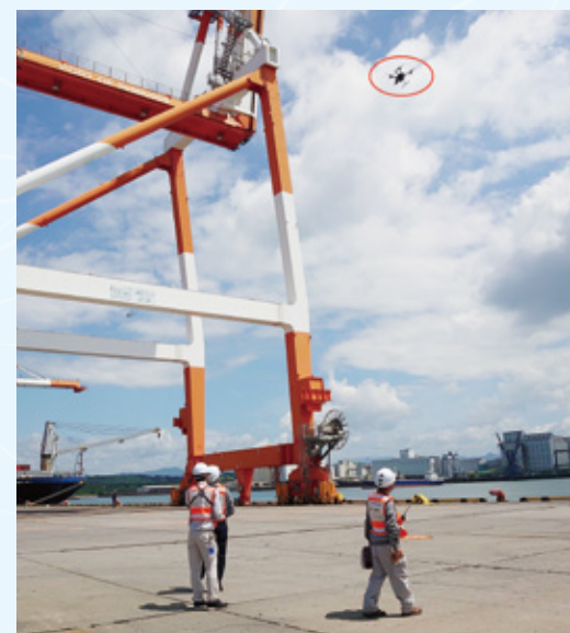
ドローン飛行による点検の様子
