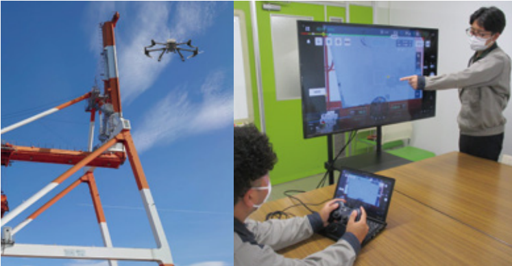
ドローンによるクレーン点検
