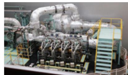
Actual SCR equipment
