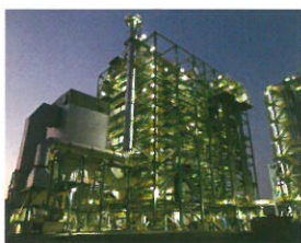
市原バイオマス発電所
