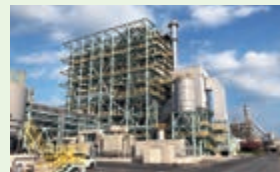
千葉県市原市のバイオマス発電所
