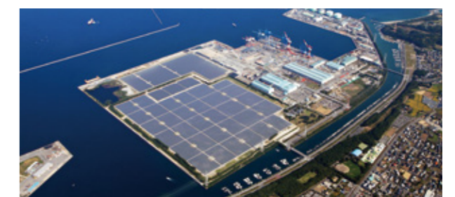
大分日吉原太陽光発電所全景
