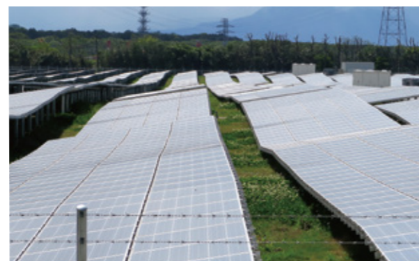
土地の雨水勾配をそのまま維持して設置された太陽光パネル
