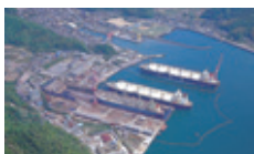
由良修繕部・鉄構部
