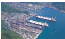
由良修繕部・鉄構部
