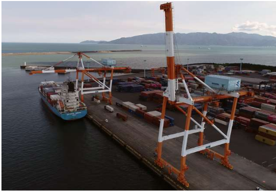
点検対象の港湾クレーン
