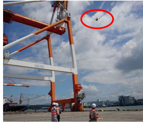
ドローン飛行による点検の様子
