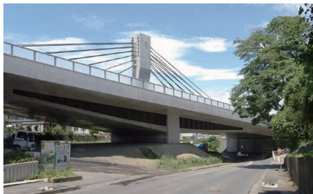
写真14 荒巻本沢大橋
