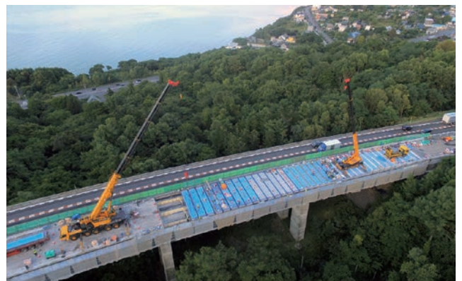
写真19 大野橋床版取替工事
