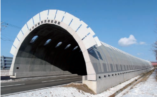
写真16 スノーシェルター
