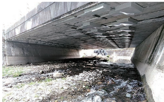
写真 20 アウトプレート工法
