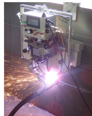
(a) 自動ガウジング施工状況 (左方向への走行) Situation of Auto Gouging (Leftward Traveling)
