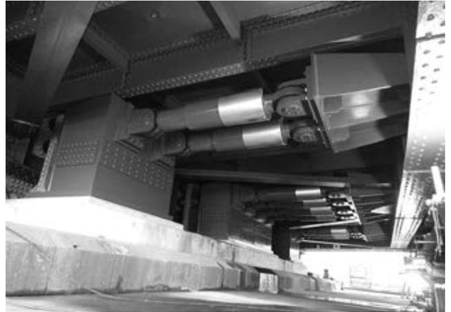
写真2 1500kN ダンパー設置完了
