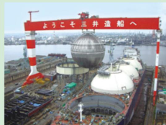
写真はMOSS型LNG船のアルミタンク(ブロック重量720T) 一体搭載風景です。
