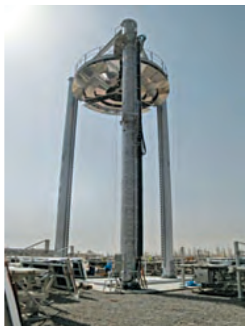
アブダビの実験設備センターリフレクタータワーと周囲のヘリオスタット
