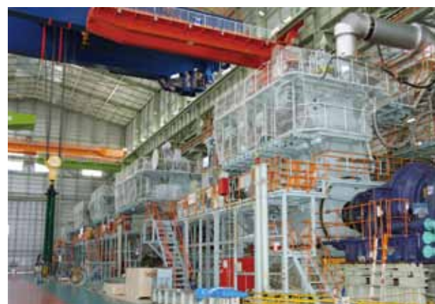
新ディーゼルエンジン組立試運転工場
